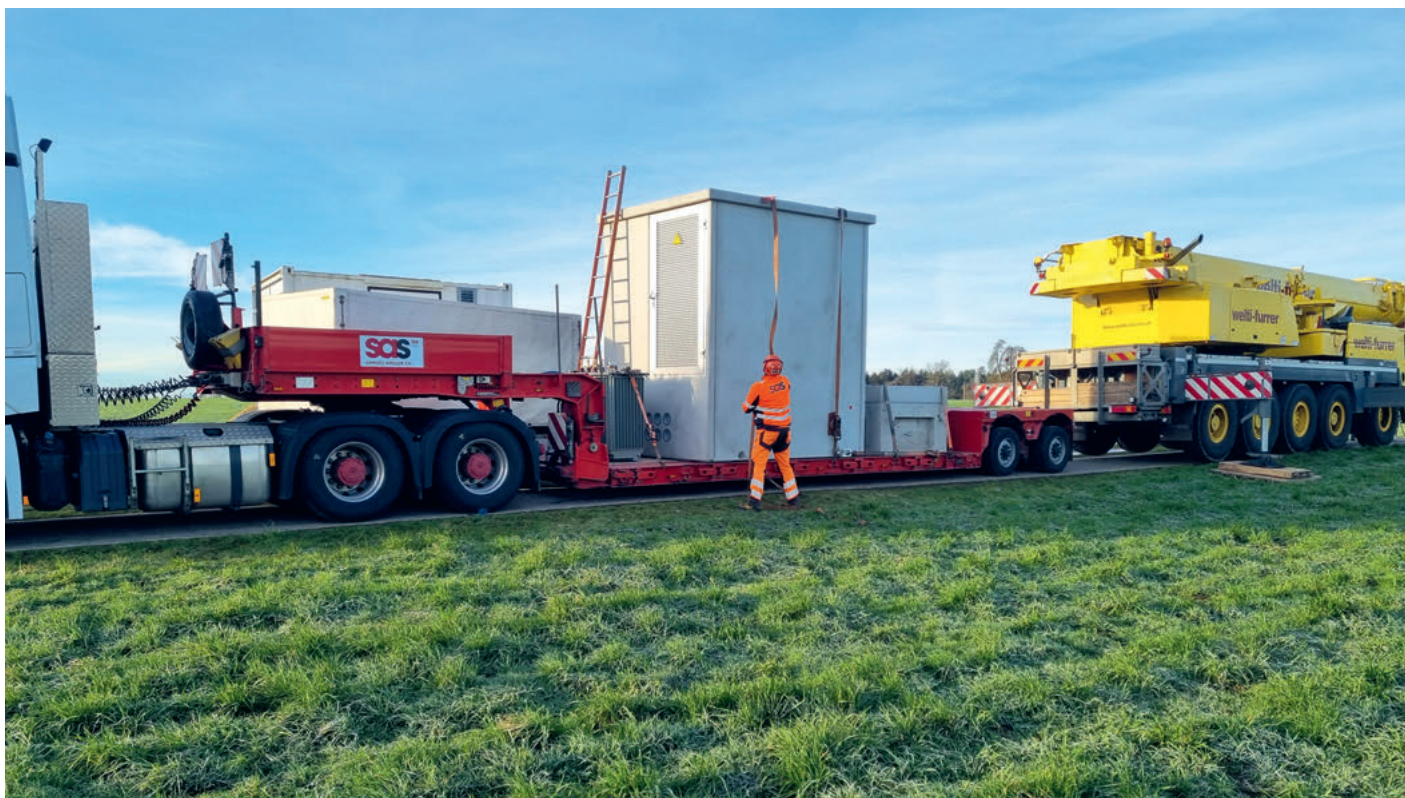
Anlieferung neue Trafostation im Weiler Bernhausen in Heldswil
