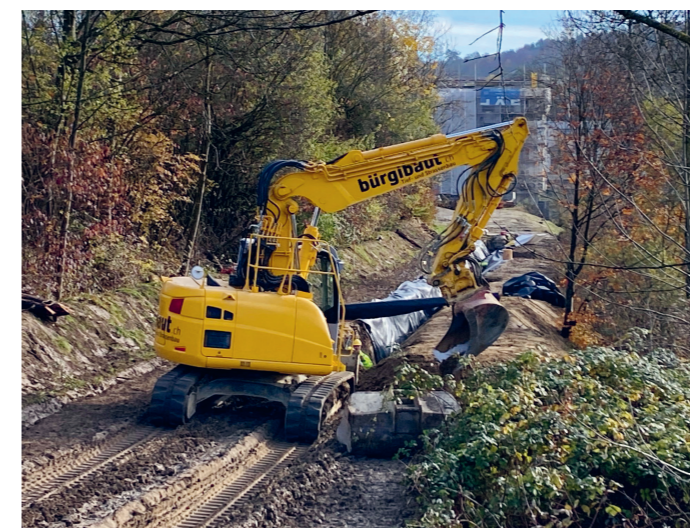
Entlang der Sitter wird derzeit die Wärmeleitung für die Überbauung Bruggmühle verlegt.
